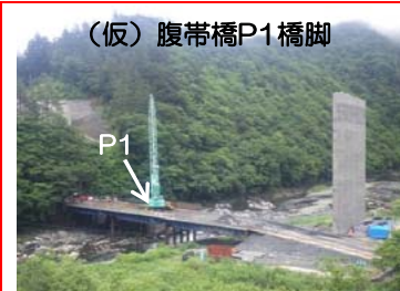
⑪施工：大豊建設
