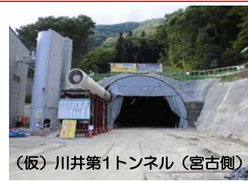
⑬施工：西松建設
