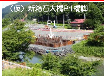
⑱施工：安藤・間
